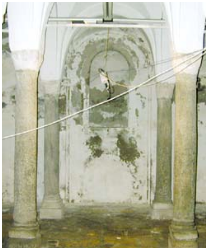
Umidità nelle murature , esempio della Cripta S. Sepolcro Milano
